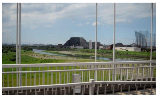
多摩川原橋より多摩川上流を見る
